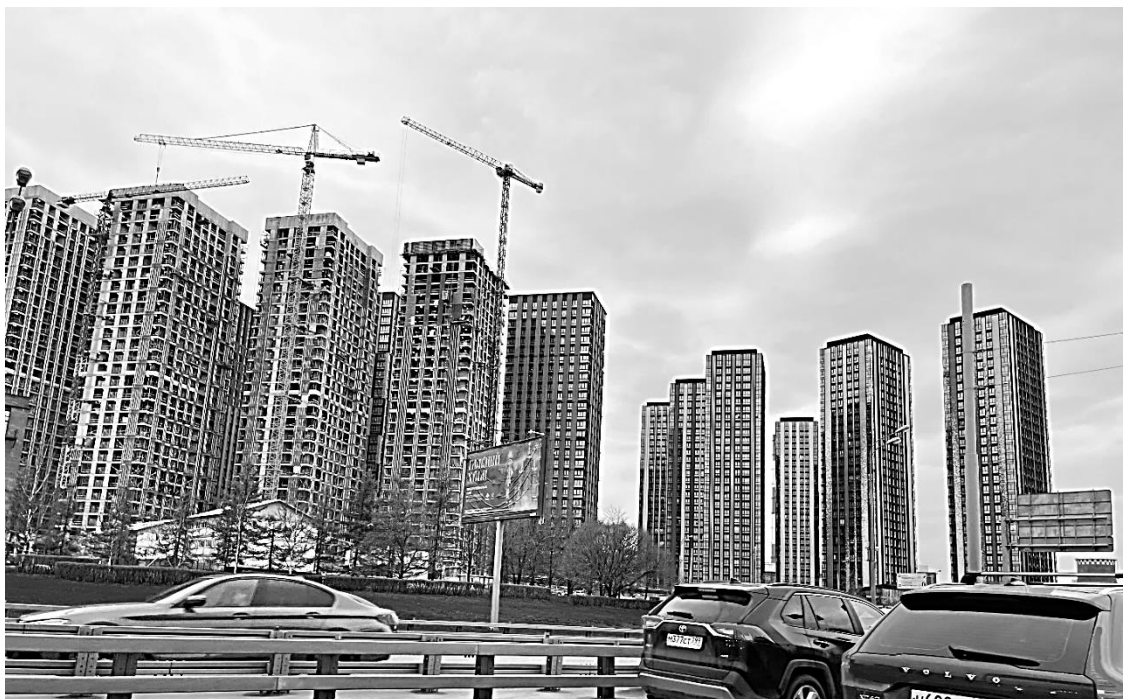
Рис. 2. Строительство коммерческого жилья в Москве. Фотография автора.
