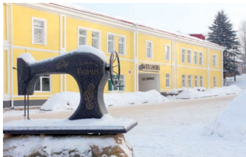
Рис. 4.8.12. Боровичи. Здание гостиницы «Ткачи» после реконструкции.
