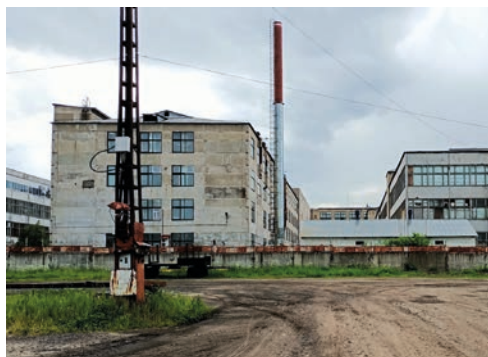
Рис. 4.4.7. Углич. Корпуса часового завода.
