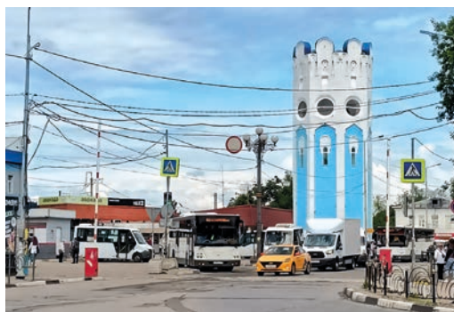
Рис. 4.2.16. Пушкино. Водонапорная башня (возможно, по проекту Л. Кекушева).
