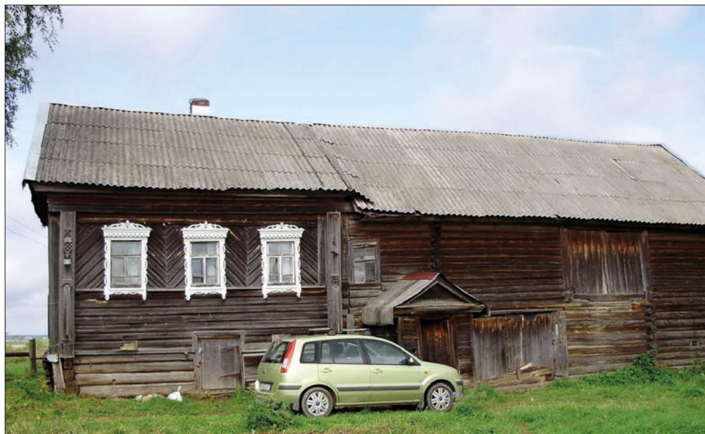
Рис. 3.5.2. Типичный деревенский дом в Костромской области из двух состыкованных срубов: жилой и хозяйственной зоны (в широкие ворота сарая по пандусу на второй этаж въезжали телеги с сеном). Ныне используется московскими дачниками.
