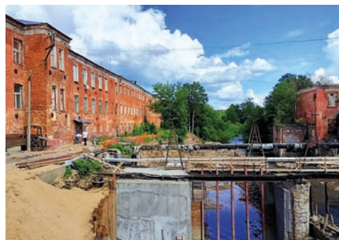
Рис. 4.2.18. Красноармейск. Здания прядильно-ткацкой фабрики «КРАФТ».
